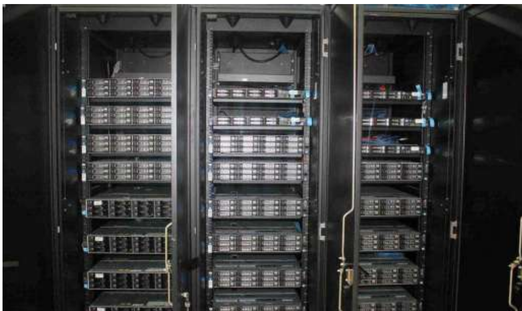
Рис. 3.9 Шкафы с блэйд-серверами
