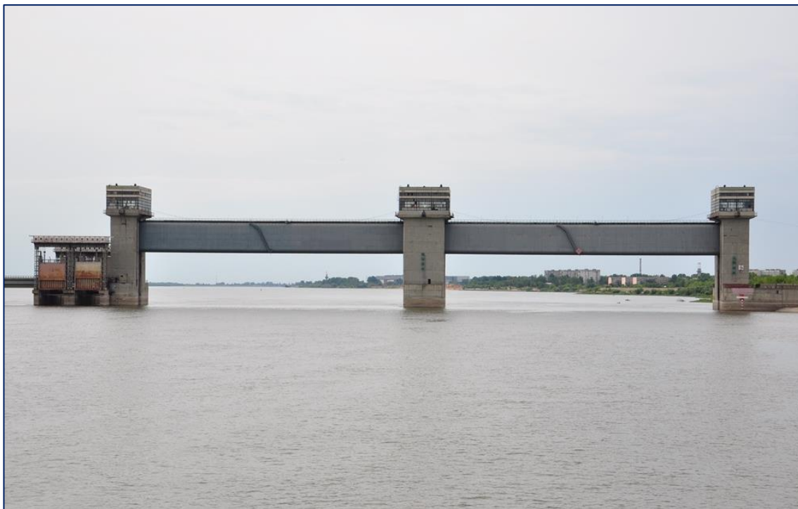
Рис. Б.3 – Фото судноплавних прольотів Астраханського вододільника з піднятими заслінками з боку верхнього б'єфу (2013 р.) [33]
