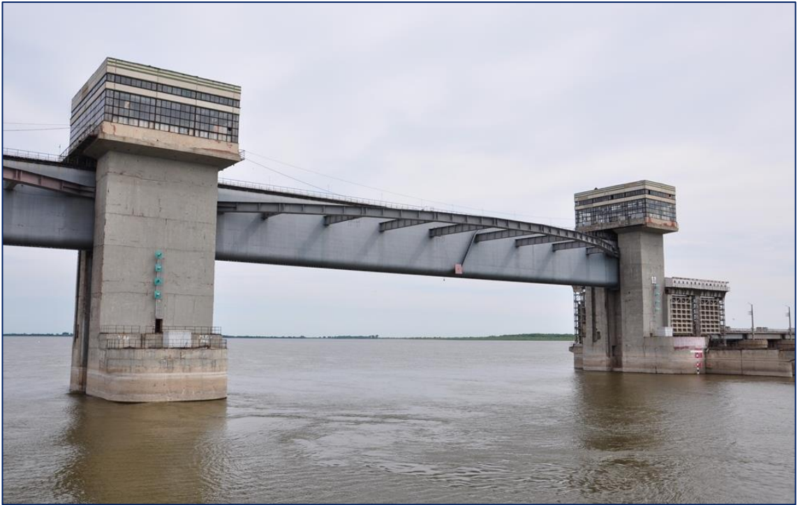
Рис. Б.7 – Фото судноплавного прольоту та бічних регуляційних прольотів Астраханського вододільника з боку нижнього б'єфу (2013 р.) [33]
