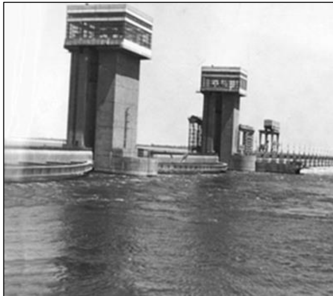
Рис. 5.3 – Астраханський вододільник у робочому стані (з опущеними затворами) [33]
