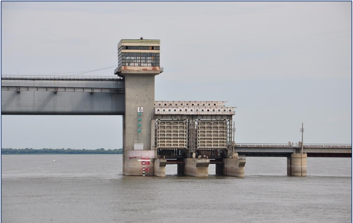
Рис. Б.11 – Фото вежі, піднятої заслінки судноплавного прольоту та бічних регуляційних прольотів Астраханського вододільника сторони нижнього б'єфу (2013 р.) [33]
