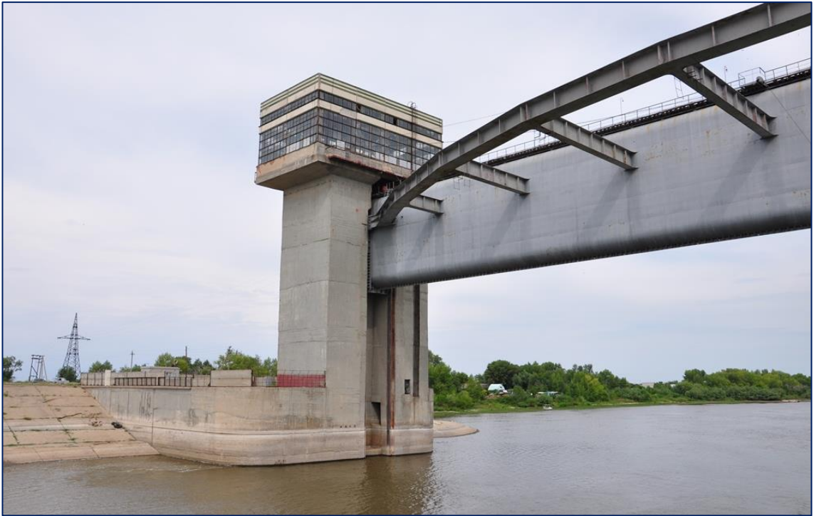
Рис. Б.9 – Фото вежі та піднятої заслінки судноплавного прольоту Астраханського вододільника сторони нижнього б'єфу (2013 р.) [33]
