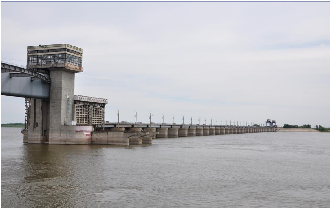
Рис. Б.10 – Фото Астраханського вододільника з піднятими заслінками з боку нижнього б'єфу (2013 р.) [33]
