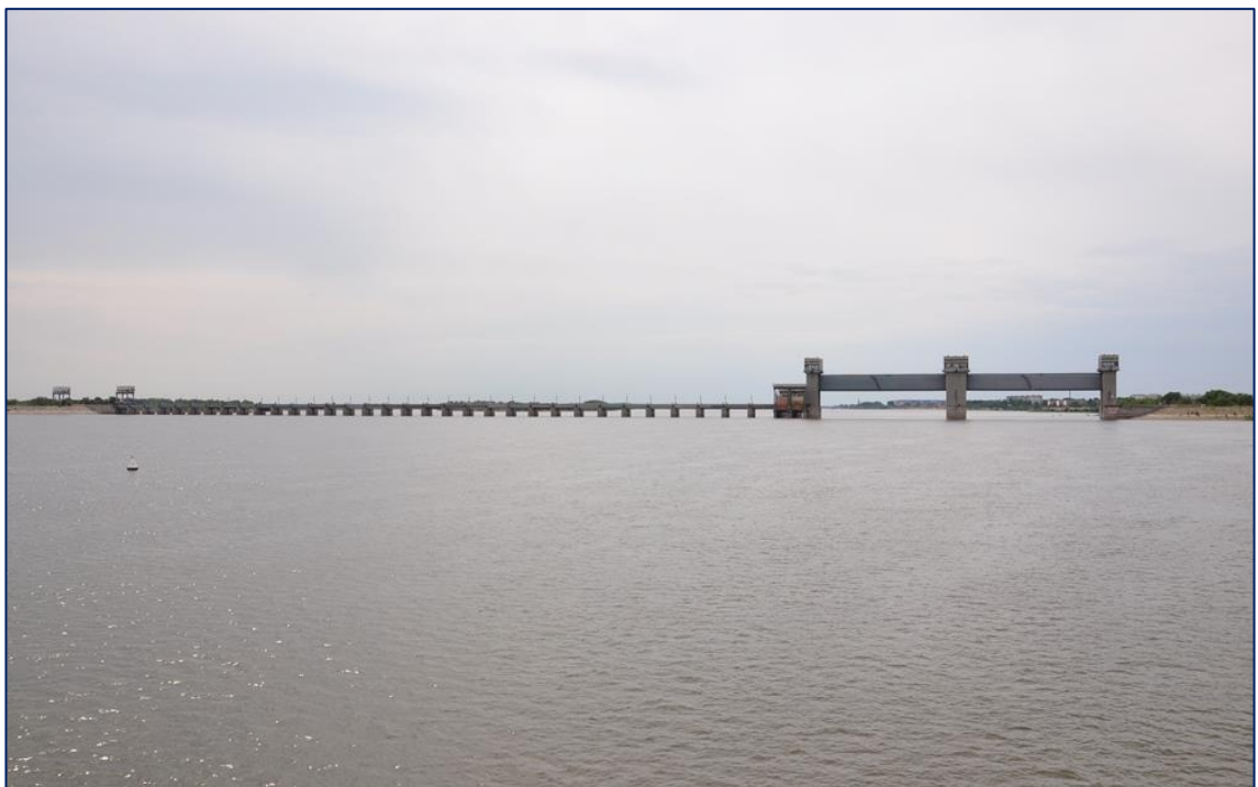
Рис. Б.2 – Фото Астраханського вододільника з піднятими заслінками з боку верхнього б'єфу (2013 р.) [33]
