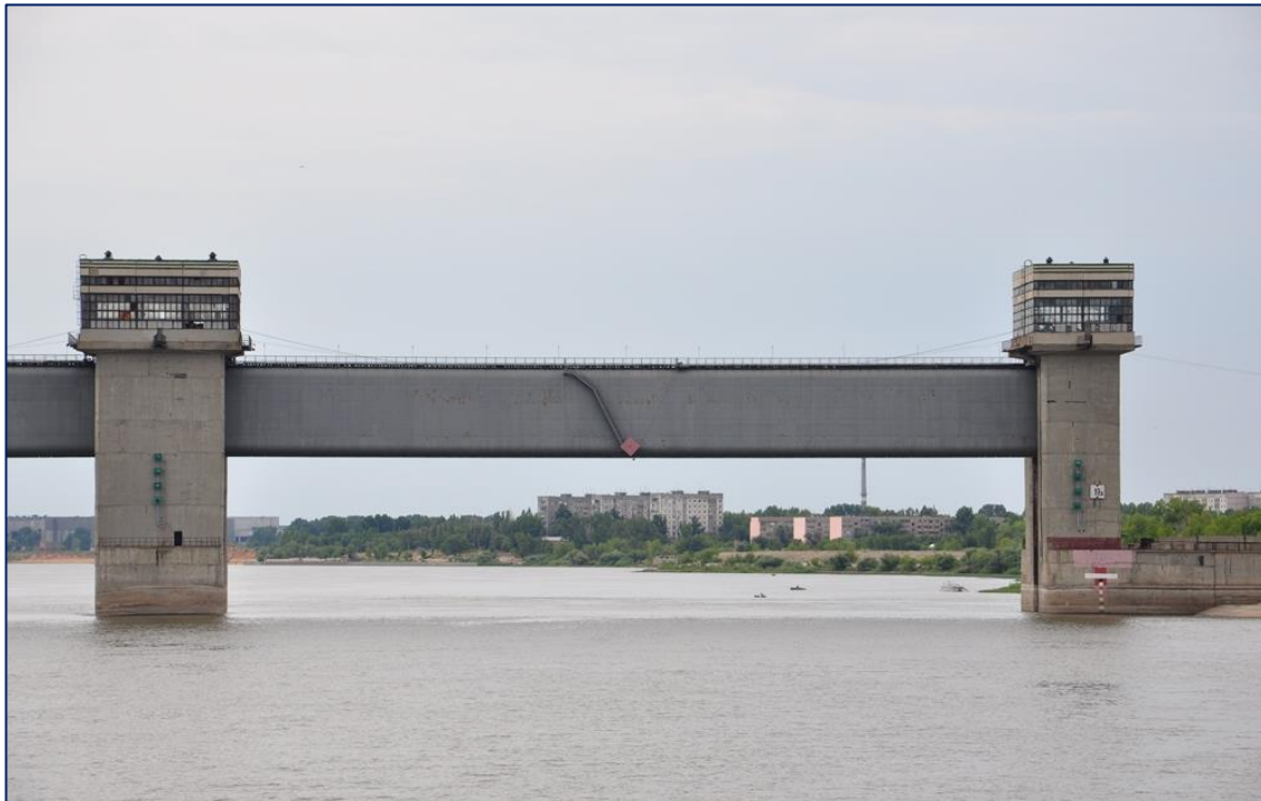
Рис. Б.4 – Фото одного із судноплавних прольотів Астраханського вододільника з піднятою заслінкою з боку верхнього б'єфу (2013 р.) [33]
