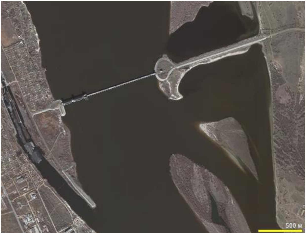
Рис. 5.4 – Супутниковий знімок гідровузла Астраханського вододільника
