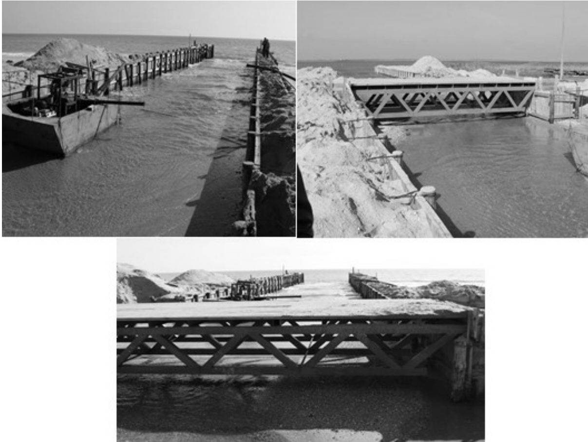
Рисунок 7.3 - Чинний обловно-запускной канал ОК "Граніт", що з'єднував Лиман Бурнас з Чорним морем (1-й км морської коси).
