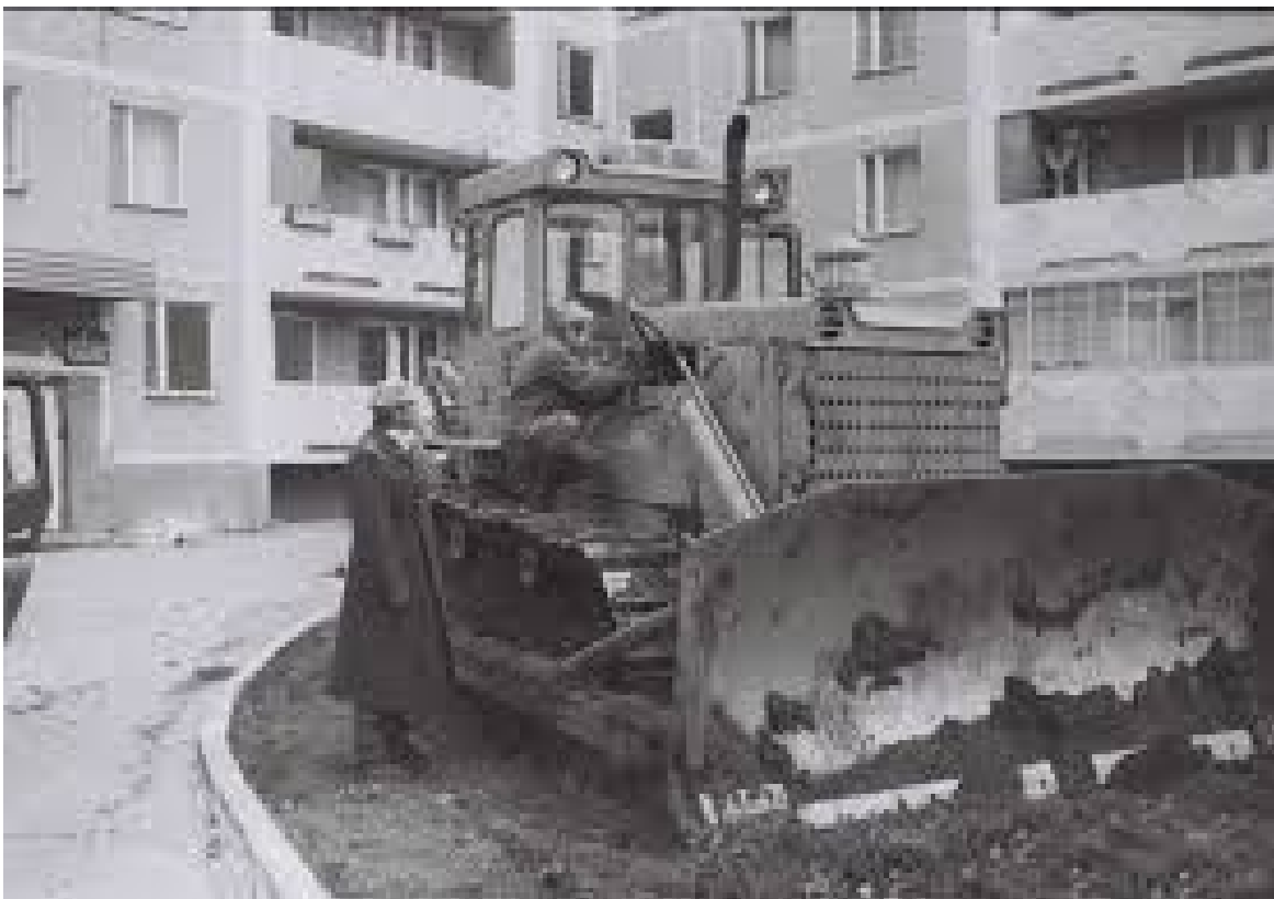
Рис.1.2 Дезактивація зняттям забрудненого шару ґрунту
