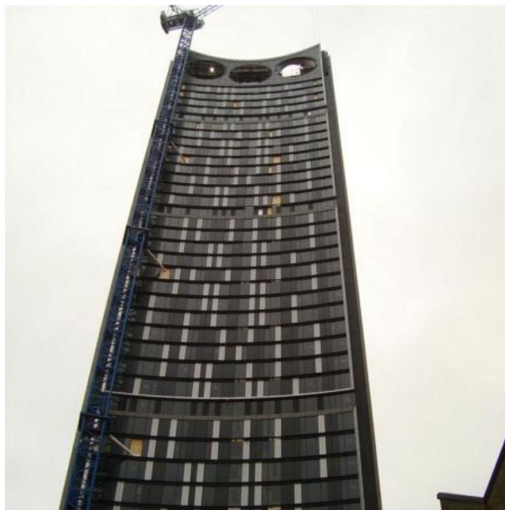
Рисунок 3.17 - Будівництво хмарочосу Strata
