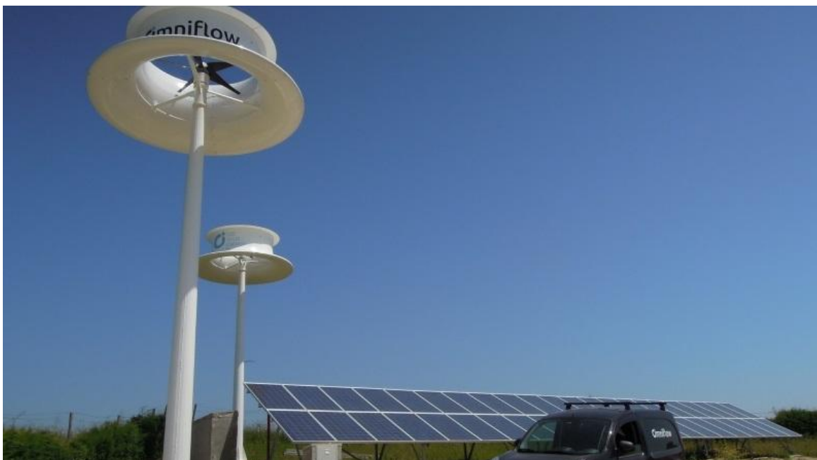
Рисунок 3.21 - Інноваційний вітряк с вертикальною віссю обертання Omniflow
