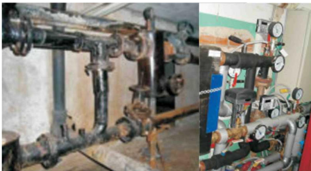
Рисунок 2.4 - Гідроелеваторний вузол старого типу й сучасний теплопункт
