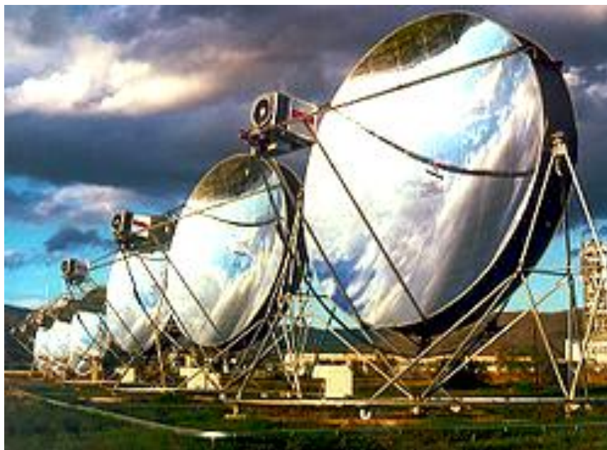
Рисунок 3.8 - Параболічні концентратори із двигуном Стірлінга в Іспанії
