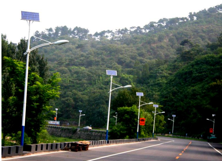
Рисунок 2.16 - Застосування сонячних панелей із акумуляторами для освітлення доріг у нічний час.
