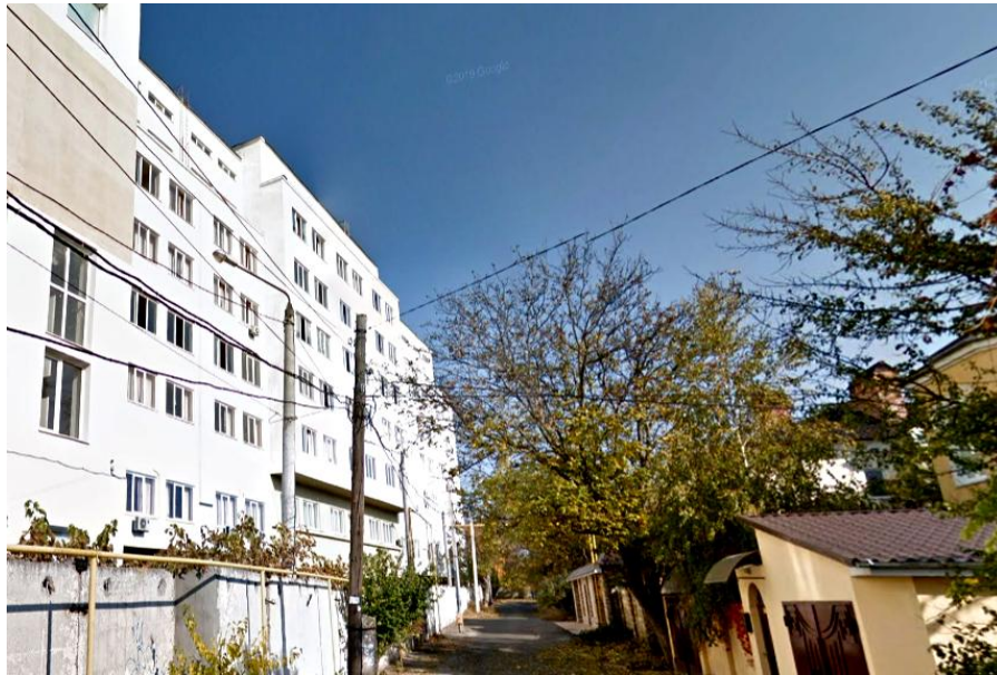
Рисунок 4.45 - Зовнішній вигляд фасаду
