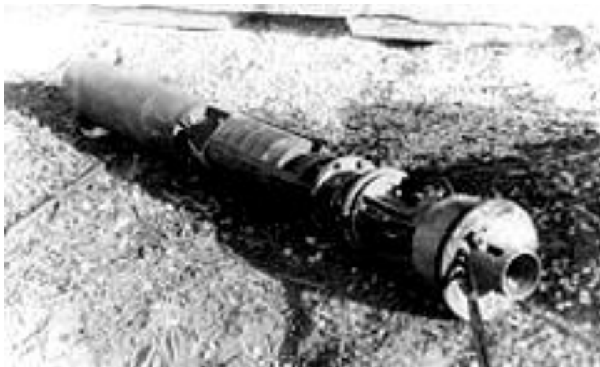
Рисунок 3.14 - Пристрій беструбного водопідйому
