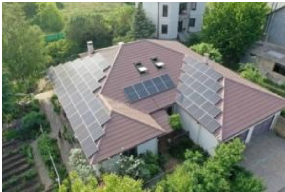
Рисунок 4.36 - Повністю встановлена система панелей
