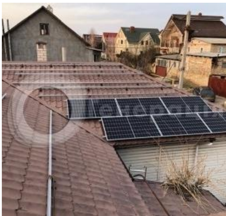
Рисунок 4.35 - Установка панелей на кріплення на даху.
