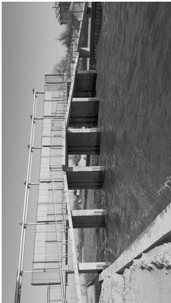
Рисунок 5.5– обловний вузол та перехідний мостик каналу Тилігульський лиман – Чорне море
