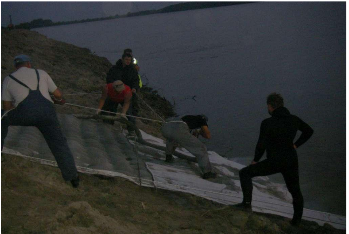
Рисунок 3.2 - Будівання захисної дамби на озері Кагул вздовж річки Дунай
