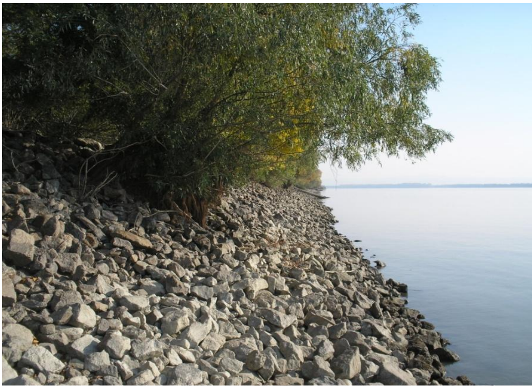
Рисунок - 6.1 - Берегоукріплення
