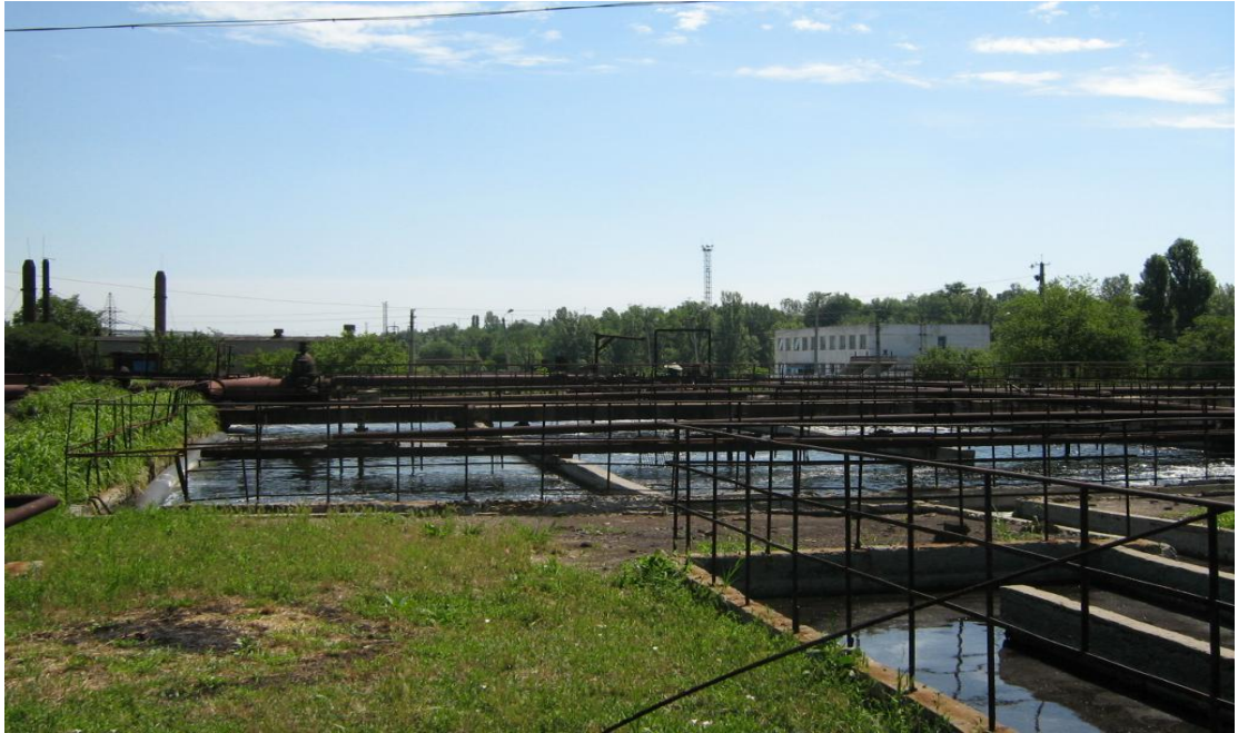
Рисунок 1.3 Очисні споруди повної біологічної очистки ЗАТ «Наdejда» м. Кривий Ріг.[12]
