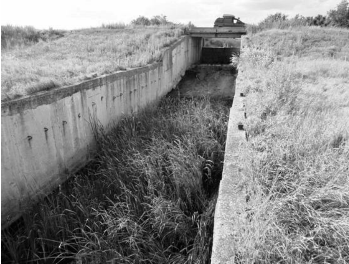
Рис. 4.7 – Нижній б'єф одного з шлюзів-регуляторів на річці В. Куяльник (станом на 27.06.2014 р.)
