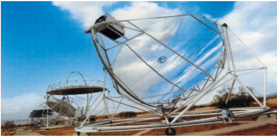
Рис. 1.3 – Сонячний прилад тарілочного типу потужністю 10кВт на сонячній електростанції в Almeria (Іспанія)
