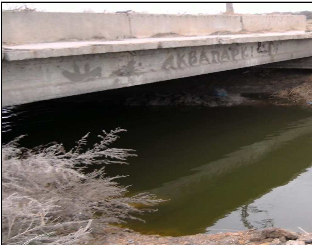
Рисунок 2.23 – Водопроектна споруда (канал) між ШВ № 2 та № 1:
