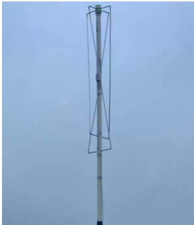
Рис. 3.9 – Квадрофілярна стаціонарна антена
