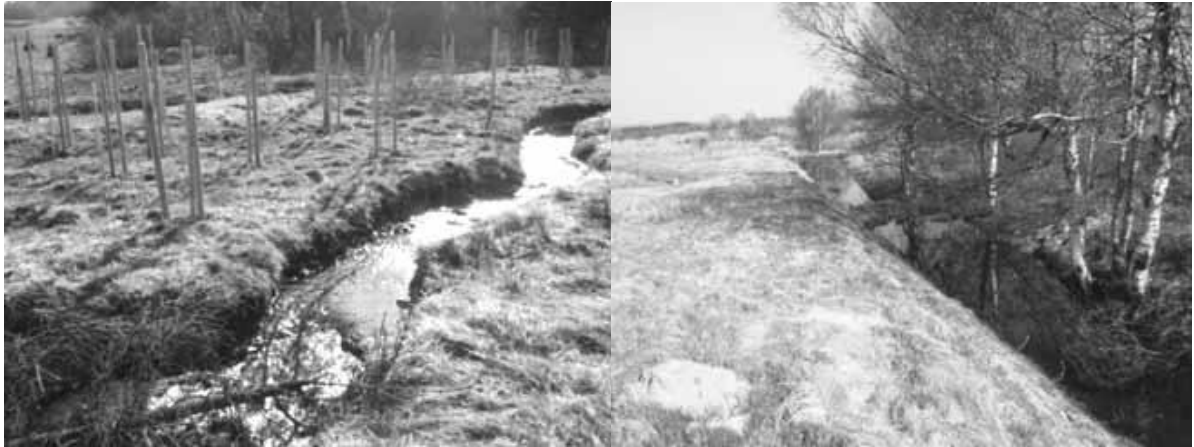
Рис. 10.7 – Зліва – нове русло струмка, праворуч – каскад ставків на старому руслі.
