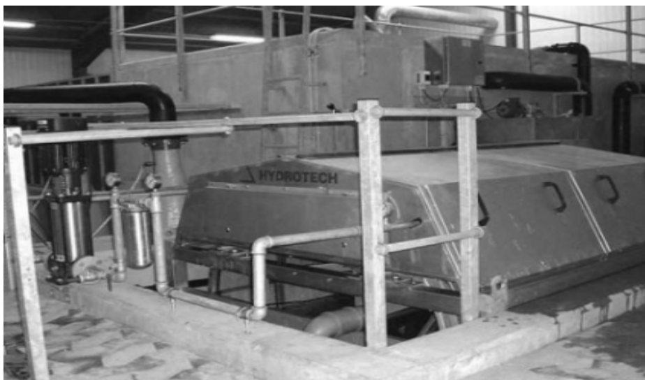
Рисунок 8.3 – Механічний барабанний фільтр промислової УЗВ
