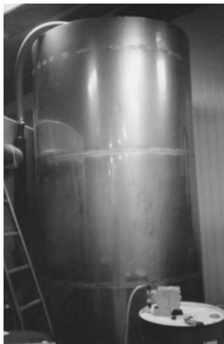
Рисунок – 8.5 Типова конструкція бака для нітрифікування із завантаженням фільтра 100 \text{ м}^2/\text{м}^3 .
