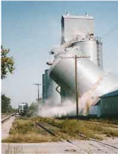
Рис.5. Непружний колапс у ємності зберігання цементу поблизу маневрової залізничної магістралі.
