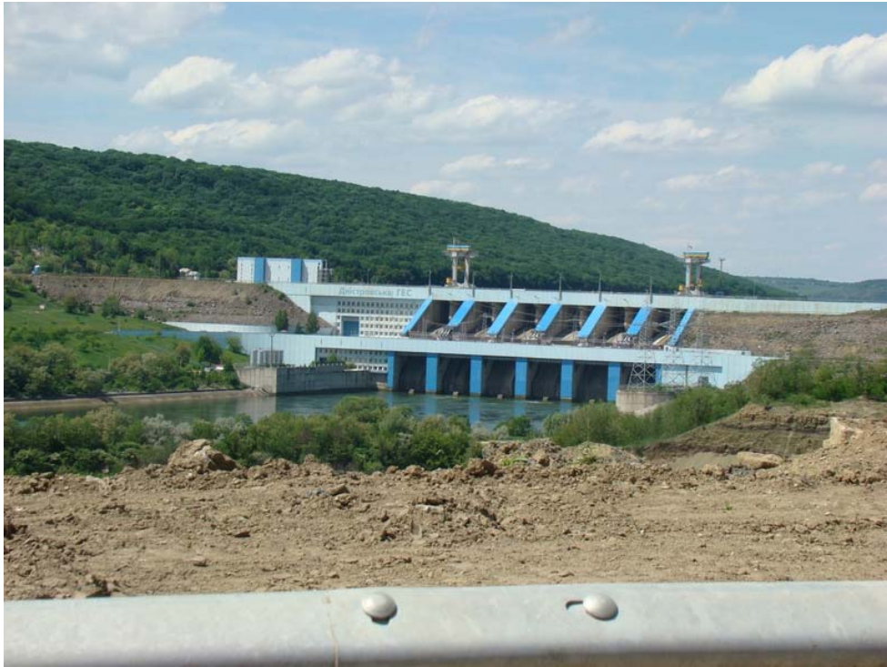
Рис. 2.3 - Гребля Дністровського водосховища з боку нижнього б'єфу
