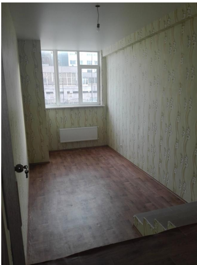
Рис 3.7 Квартира №342. Спальне приміщення 1
