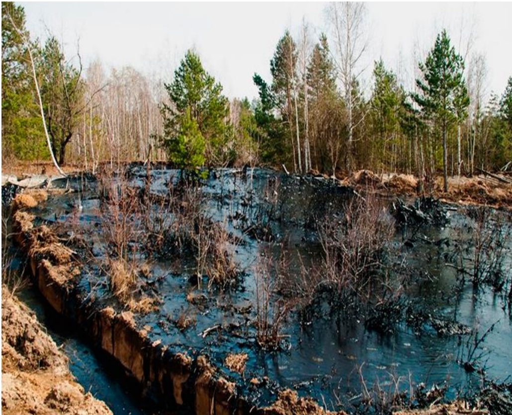
Рис. 1.1 - Обвалування місця розливу нафтопродуктів [35]
