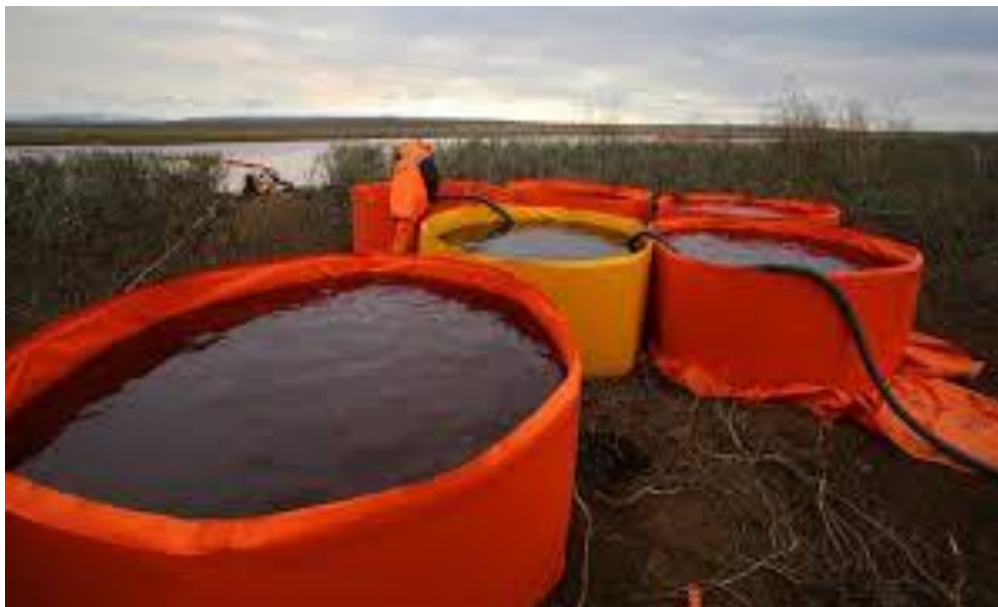
Рис. 2.2 - Збір нафтошляму у тимчасові ємності [13]
