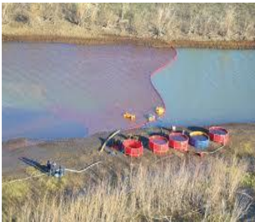
Рис. 2.1 - Локалізація розливу за допомогою бонових загород [35]
