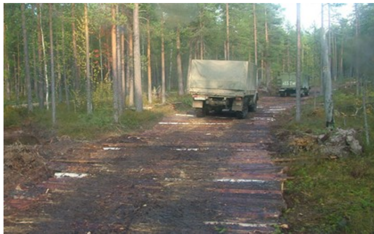
Рисунок 35 - Колонний шлях (гатка) в лісисто-болотистій місцевості
