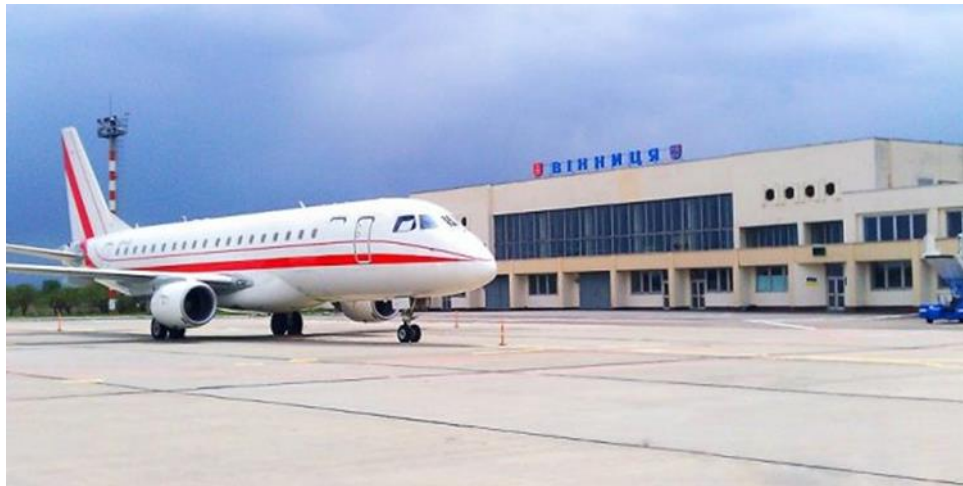
Рисунок 1.2 - Зовнішній вигляд аеропорту «Вінниця» [8]
