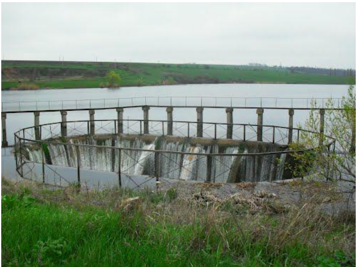
Рисунок 2.1 - Водоскид шахтного типу гідровузла Синицівського водосховища.
