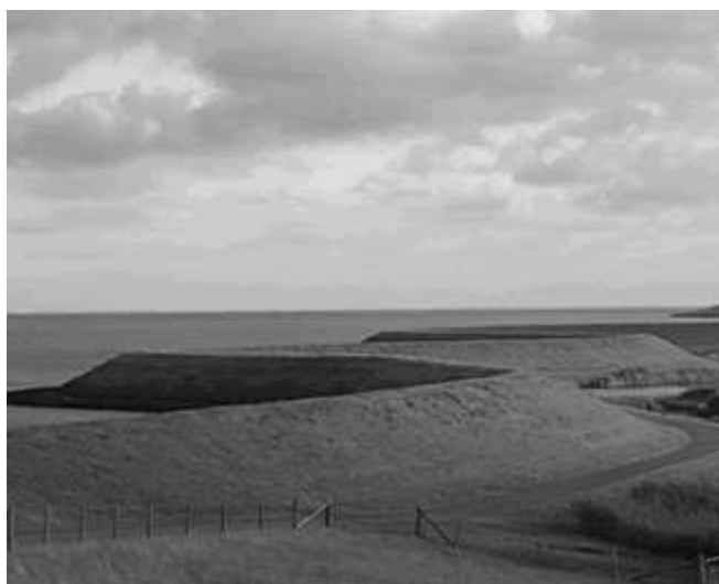
Рис. 3.4 – Зовнішній вигляд водоогороджуючої дамби.
