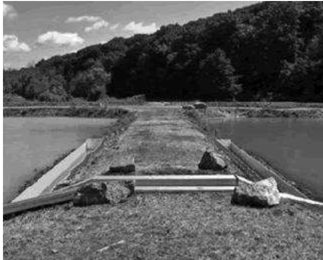
Рис. 3.3 – Зовнішній вигляд роздільної дамби
