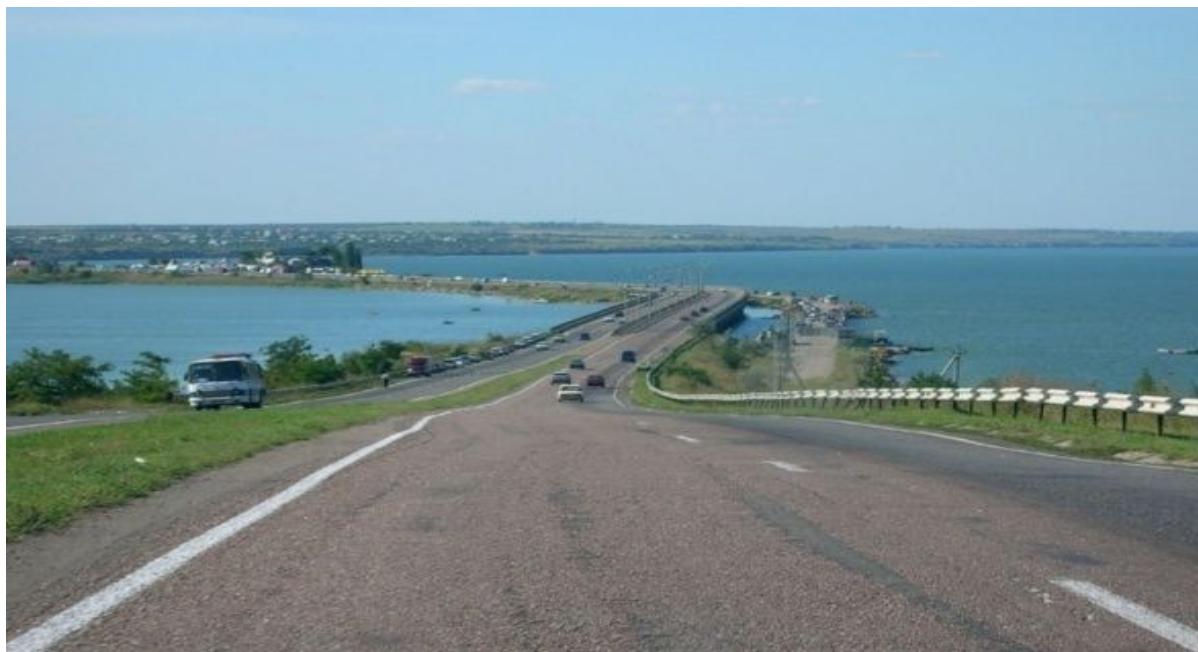
Рис. 6.8 – Фотоснимок автомобильной дороги вдоль дамбы Хаджибейского лимана
