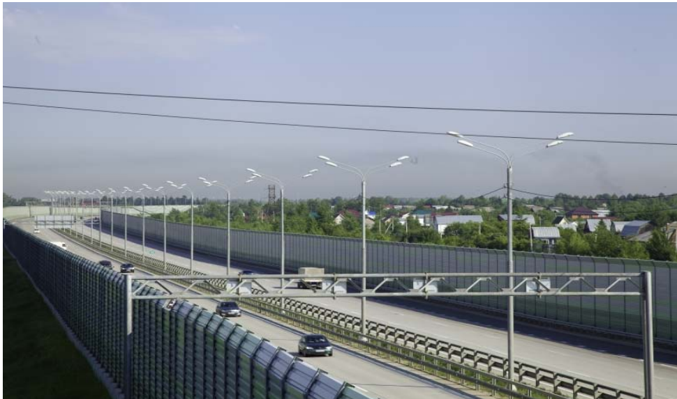
Рис. 3.2 – Приклад екрануючих шумозахисних споруд вздовж автомагістралей
