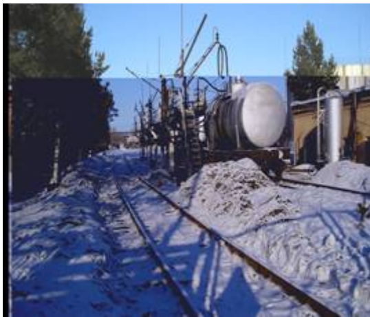
Рис.24 - Склад палива станції
