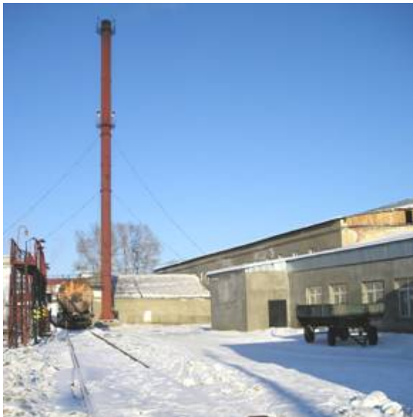
Рис. 5. Котельня локомотивного депо
