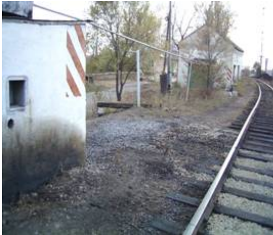
Рис. 25 - Місця проток дизельного палива на складі зберігання палива
