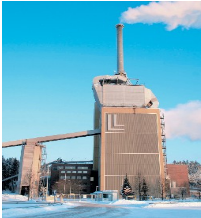
Пилевугільна станція «Куміярві» (Фінляндія), де одночасно спалюється сміття з вугіллям при роздільній їх подачі
