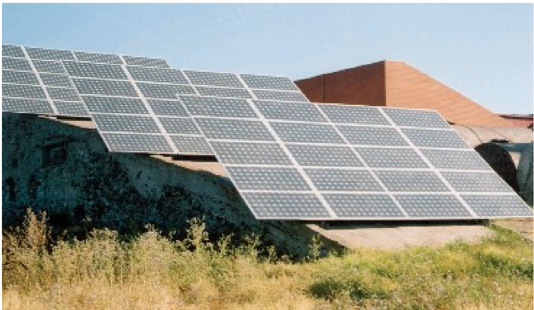
Рис.3.13 - Фотоелектрична система енергопостачання комплексу на о. Зміїний потужністю 10 кВт
