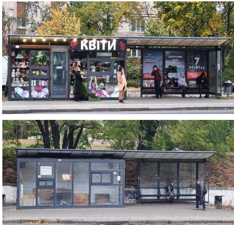
Рис. 4.2 Зовнішній вид зупинок громадського транспорту в м. Київ
