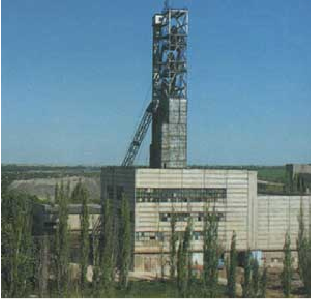
Рис. 1.17 – Вид на будівлі Інгульської уранової шахти [5]
